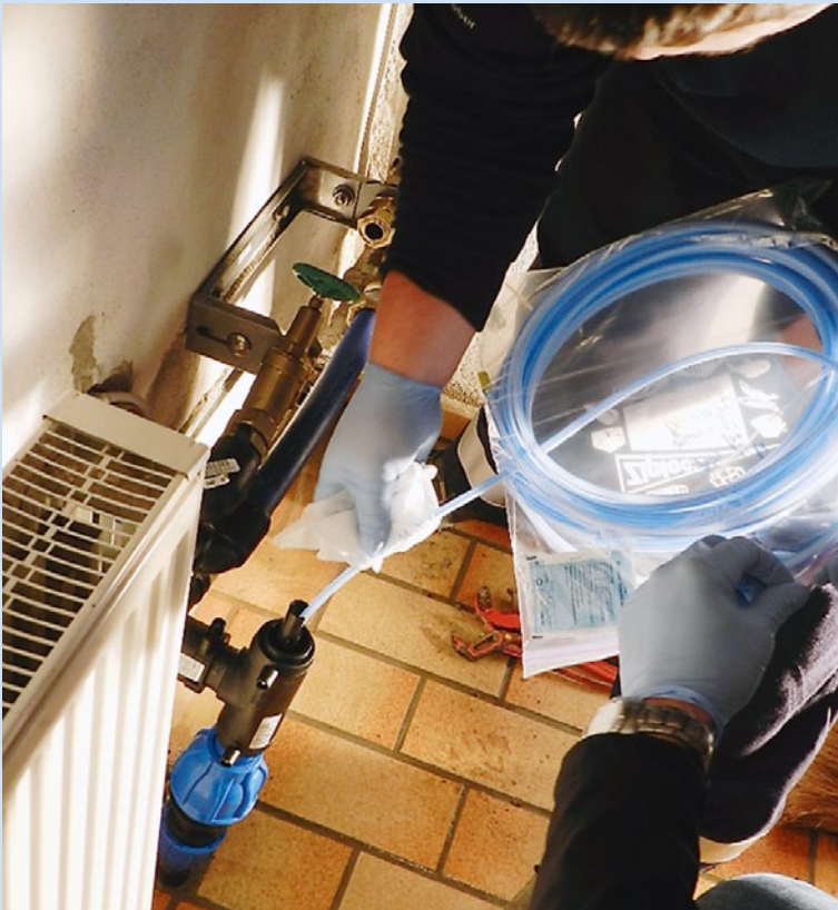
Bild 5. Einbringung des innenliegenden Leerrohres d7 mm.
