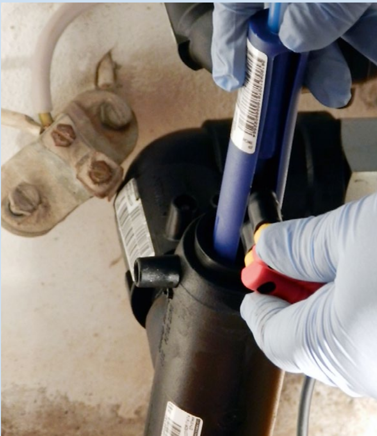
Bild 6. Montage des Schweißelementes d7 mm.
