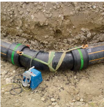
■ Mit einem FRIAMAT-Schweißgerät wurden die PE-Bögen verschweißt.
