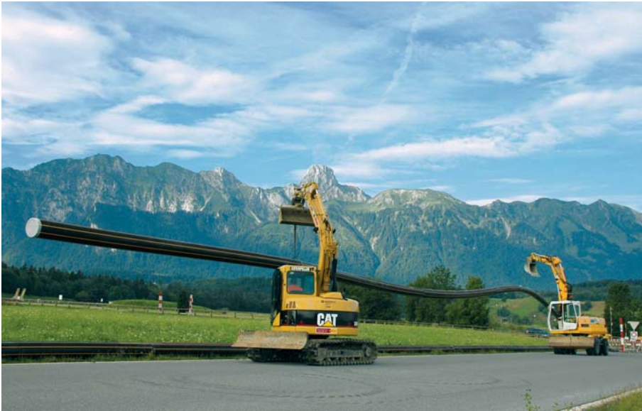
■ Bagger transportierten die vorgeschweißten Rohrstränge zum Einbauort.
