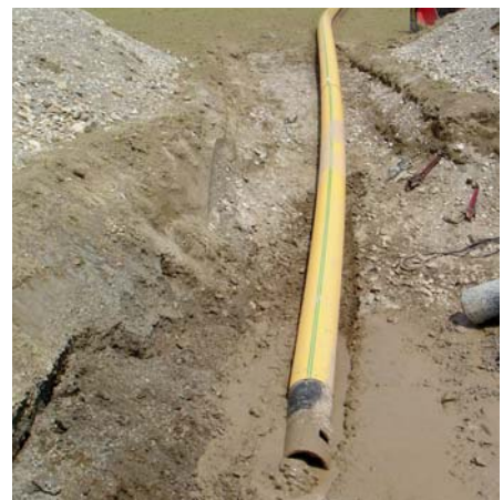
■ Vorbereitung des Einzugs eines Rohrstranges in die Horizontalspülbohrung.
