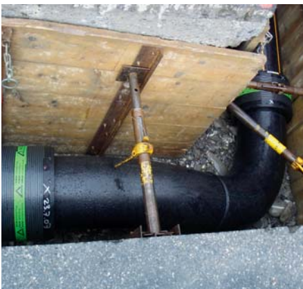
■ Etage und 90° Bogen – Rohrführung unter beengten Platzverhältnissen.
