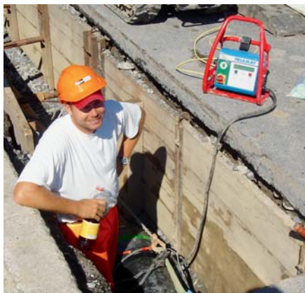
■ Mit einem FRIAMAT-Schweißgerät wurden die PE-Formteile verschweißt.
