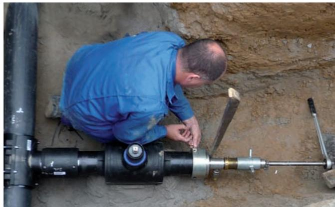
Abb. 3: Anbohrung über Standard-Flansch, Schieber und SAFL
