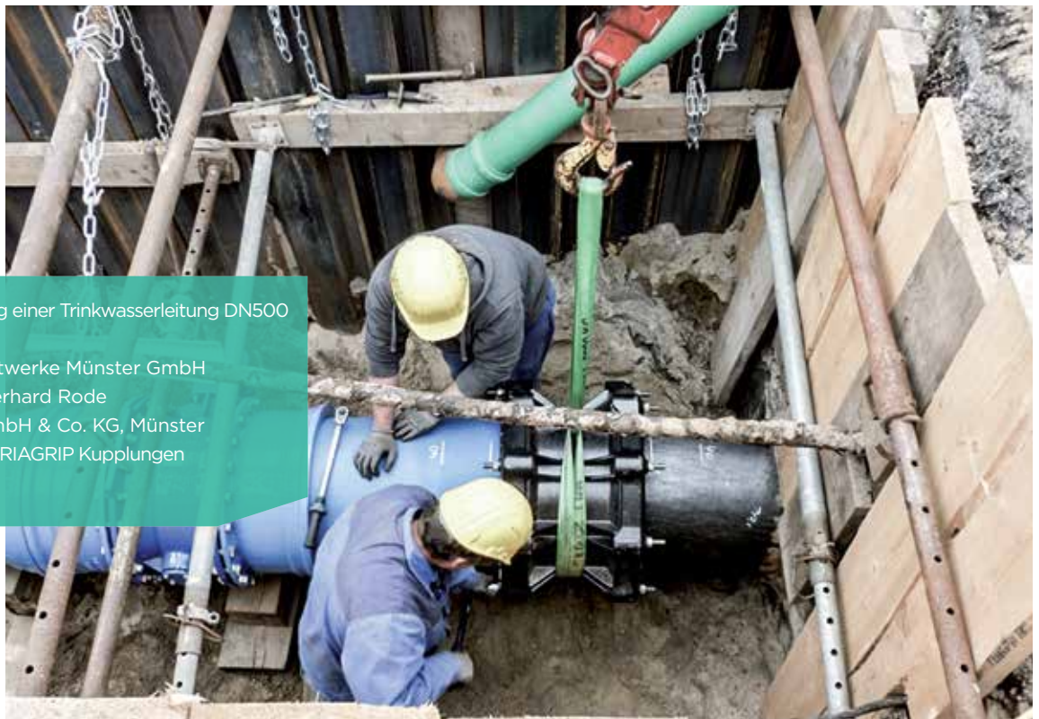
Überprüfung des Anzugsdrehmoments mittels Drehmomentschlüssel
