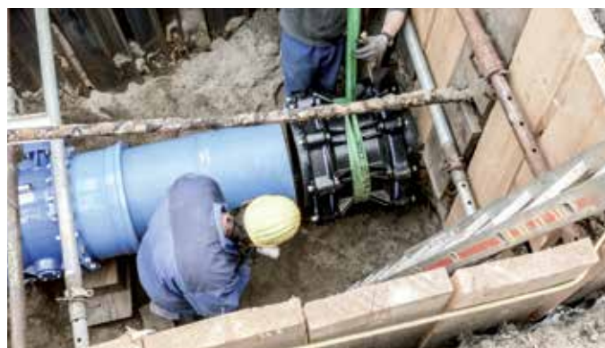
Einbindung Baugrube Nord
