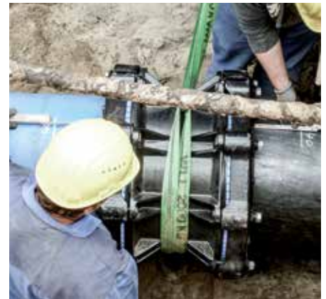
Überprüfen der Position der FRIAGRIP Kupplung
