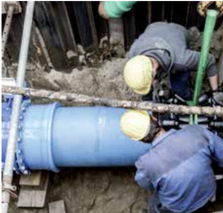
Ausrichten der FRIAGRIP Kupplung
