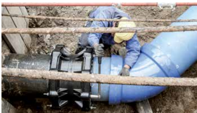
Einbindung Baugrube Süd
