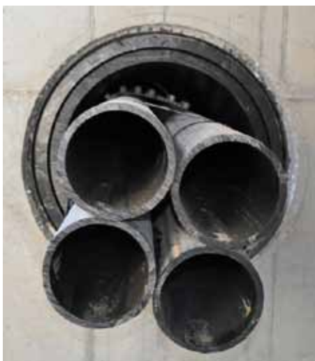
■ Eine technisch ausgereifte PE-Rohr-Anbindung an den Betonschacht durch FRIAFIT-ASF und -AEM.
