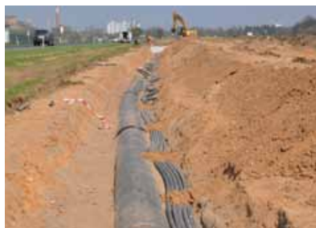
■ Rohrtrasse in Richtung Kelsterbach
