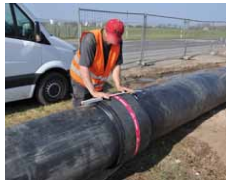
■ Verbindung des Schutzrohres d 630 mit der FRIAFIT-Muffe AM d 630.
