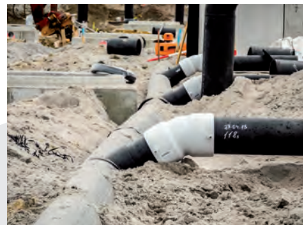
Homogen geschweißte PE-HD Leitung
