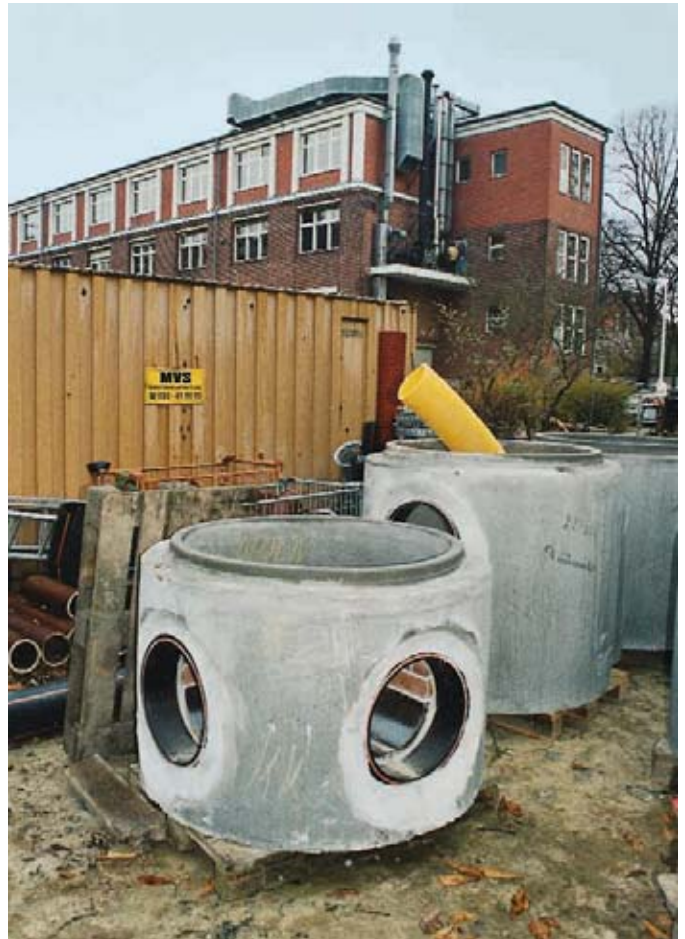
Bild 4: Betonschächte mit FRIAFIT®-Abwasserschachtfutter versehen
