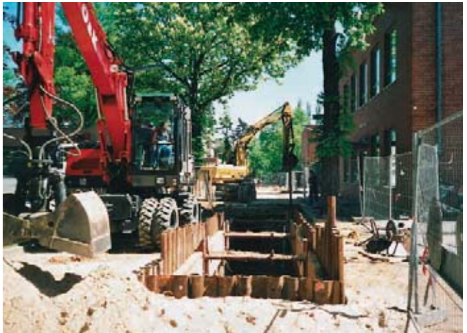
Bild 1: Anlegen des Rohrgrabens in unmittelbarer Baumnähe
