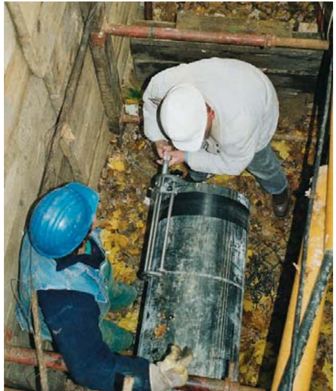
Bild 6: Baustelleneinweisung: Schalen eines PE-HD Rohres d 450 mit dem FRIATEC-Schälgerät FWSG 630
