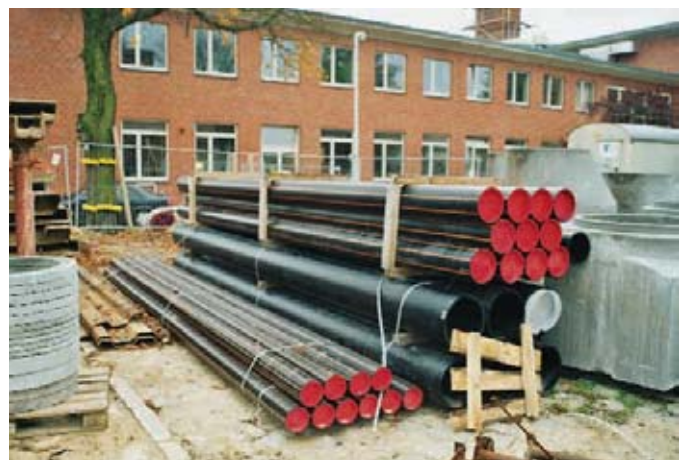
Bild 2: PE-HD Rohre und Betonschächte kurz vor dem Einbau
