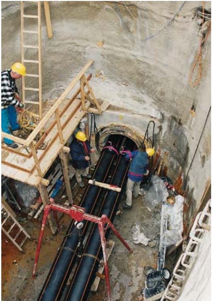
Bild 1: 6 Meter lange PE-HD Rohre im Doppelpack im 8 Meter tiefen Kopfloch
