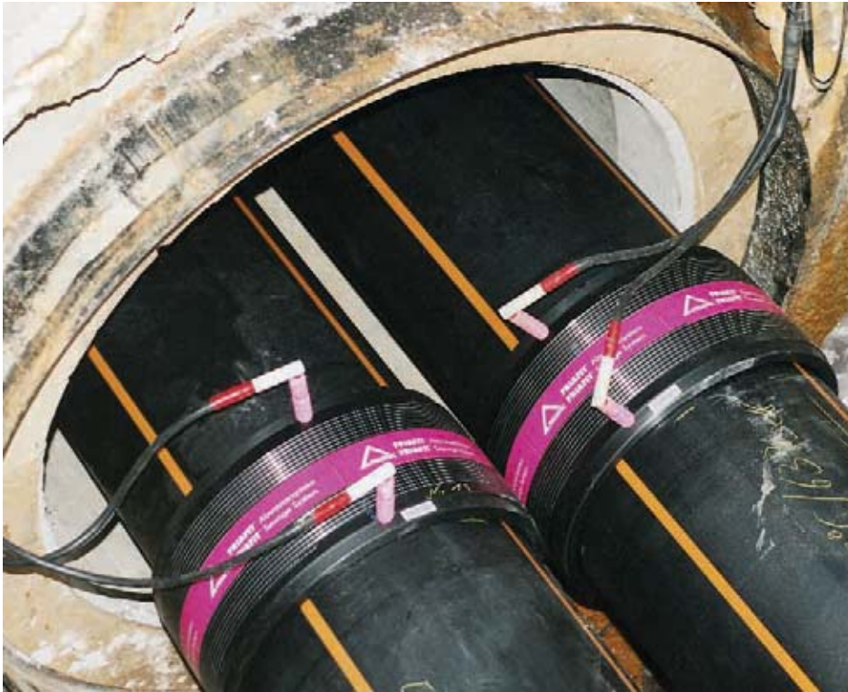
Bild 3: FRIAFIT®-Verschweißen der Muffen mit den Rohren
