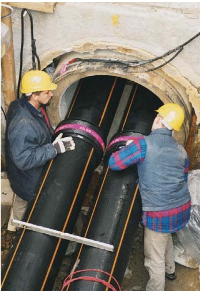
Bild 2: Einmessen der Rohre und der FRIAFIT®-Muffen an den bereits eingezogenen Rohrstrang
