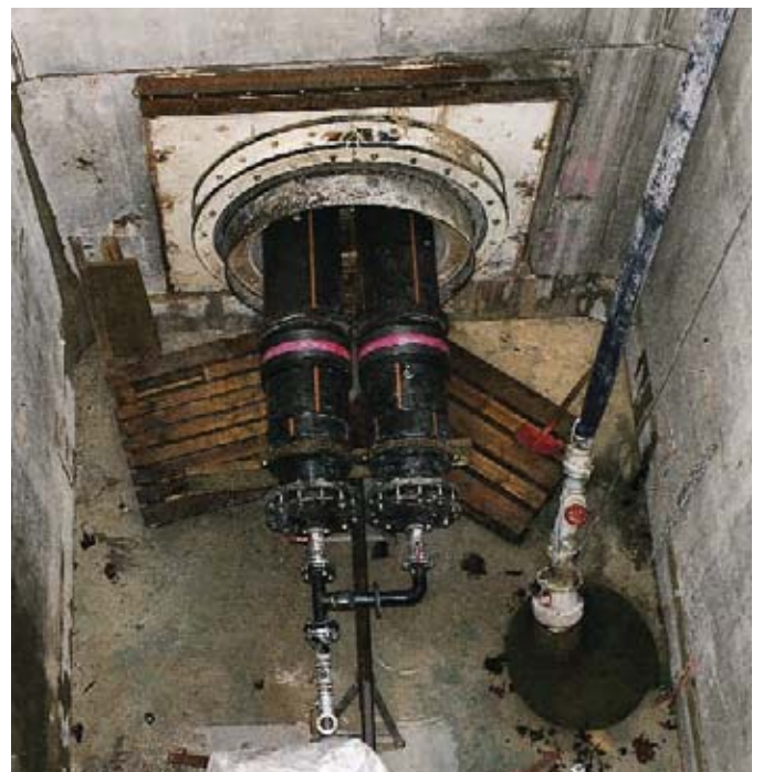
Bild 4: Druckprobe mit 9 bar Wasser am eingezogenen Rohrstrang
