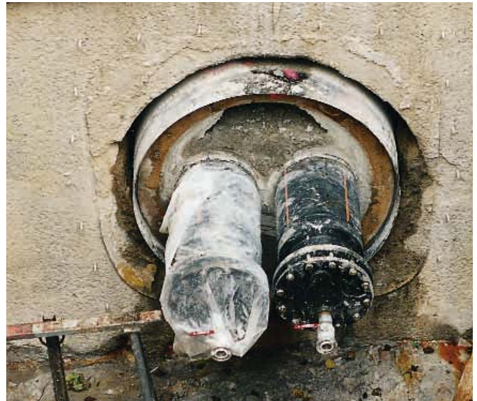
Bild 5: PE-HD Rohrstrang mit Porenleichtbeton umgossen
