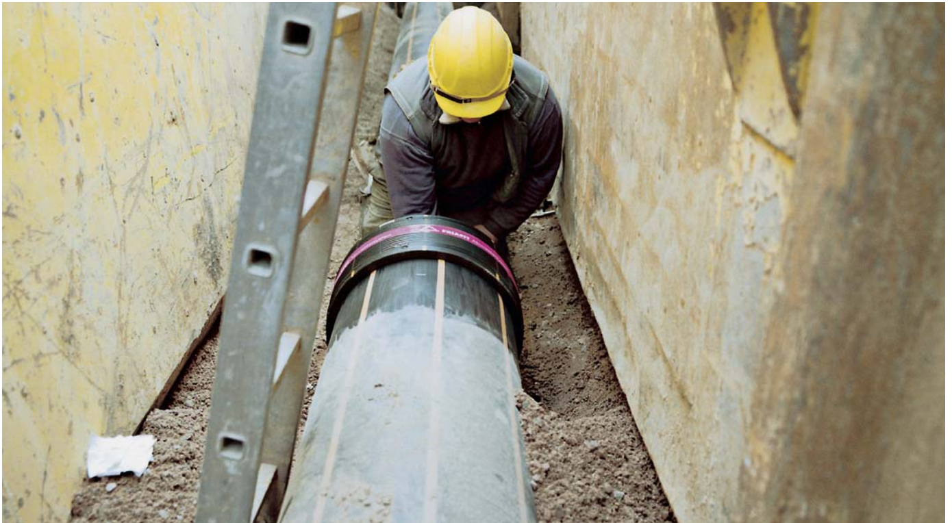
Bild 1: Verlegung einer mit FRIAFIT®-Muffe AM geschweißten PE-HD Abwasserleitung
