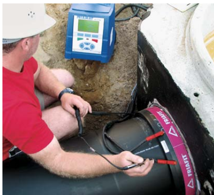
■ Einfache Anwendung mit dem kompakten Schweißgerät FRIAMAT.
