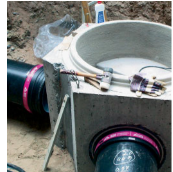
■ Anbindung einer PE-HD-Abwasserleitung an einen Betonschacht
