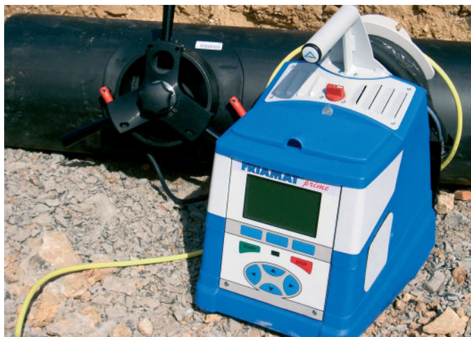
■ FRIAMAT-Schweißgeräte werden automatisch über den auf den FRIAFIT-Fittings angebrachten Barcode gesteuert.
