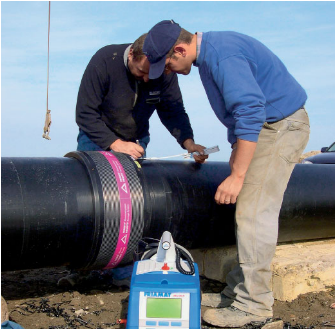
■ Homogene Verbindungen durch Heizwendelschweißen
