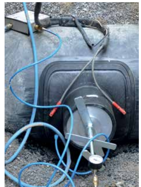
Schweißung Abwassersattel ASA VL d 630/225
