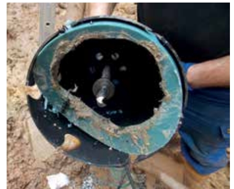
Bild 8: Absatzfreies Anbohren ist gewährleistet
