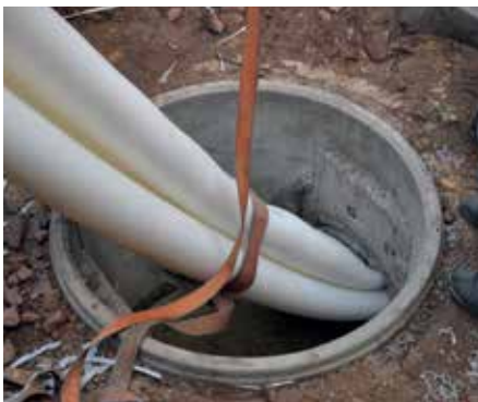
Bild 1: In der Wiesenstraße: PE-Liner wird über Revisionschacht eingezogen
