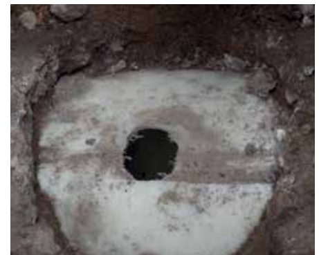
Bild 3: Freigelegter PE-Liner mit Notabfluss in Fensteröffnung
