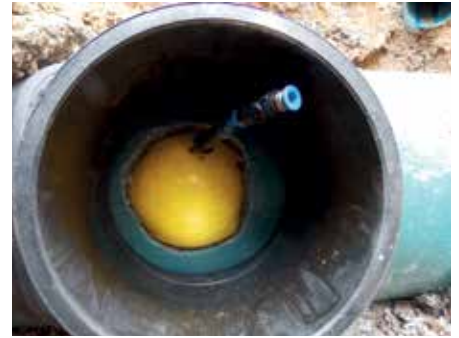
Bild 7: Ballon zur Abdichtung der Notöffnung nach der Schweißung
