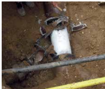
Bild 2: Altrohr wird am Anschlusspunkt zerstört
