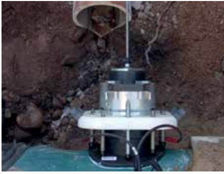
Bild 4: In der Wolfshohlstraße: Abwassersattel ASA-TL montiert mit kompaktem Aufspanngerät ASATOP
