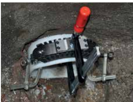
Bild 9: Anwendung FIXBLOC als Einzugsicherung bei der Schachtanbindung
