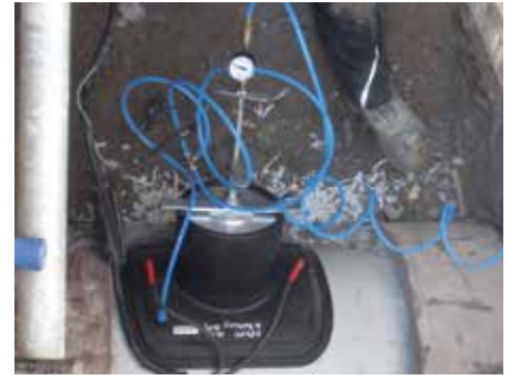
Bild 6: Mit VACUSET XL aufgespanntem Abwassersattel ASA-VL mit Abgang d 225
