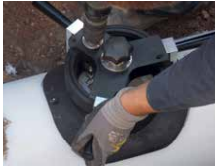
Bild 5: Anbohrgerät FWFIT im Einsatz
