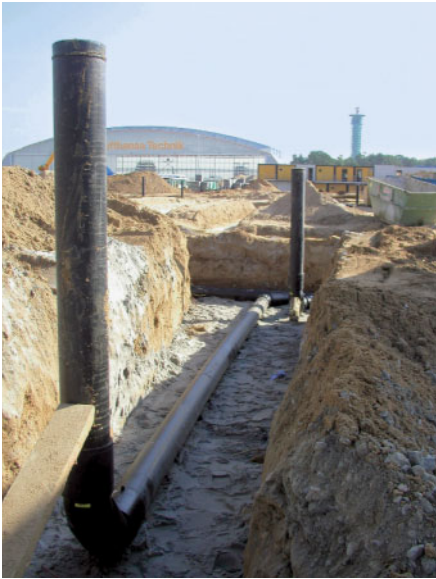
■ Komplett geschweißte PE-HD Leitung
