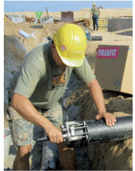
■ Schälen eines PE-HD Rohres mit FRIATOOLS-Schälgerät
