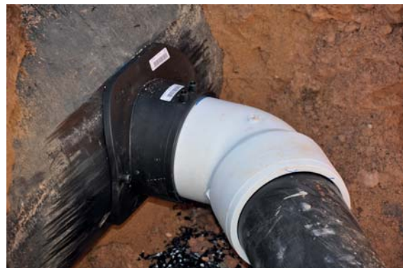
Abb. 5: Anschluss mit Abwassersattel ASA TL und -bogen ABMS
