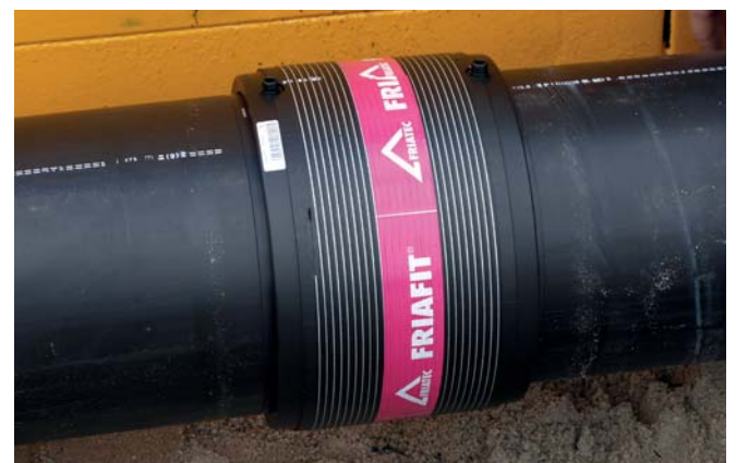
Abb. 2b: Fertige Rohrverbindung
