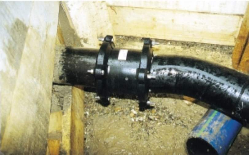
Bild 4: Einbindung einer PE-HD-Leitung d225 SDR 11 in eine bestehende Asbestzement-Wasserleitung DN 200 PN 10
