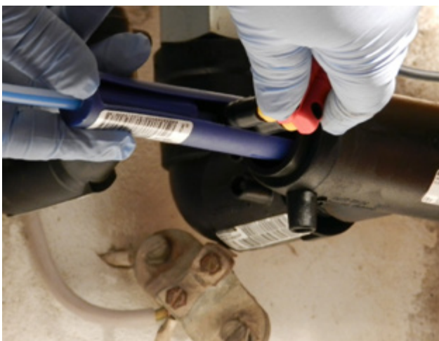
Bild 2: Einbringung des innenliegenden Leerrohres d 7 mm
