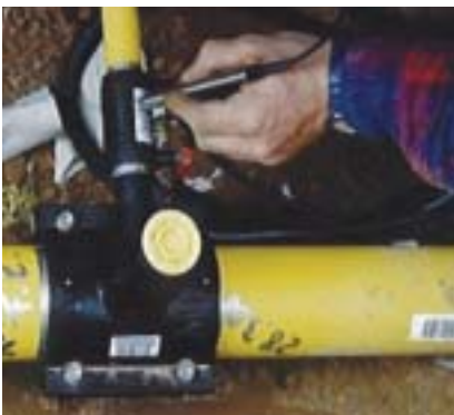
Abb. 5: Einlesen von Schweiß- und Traceability-Parametern
