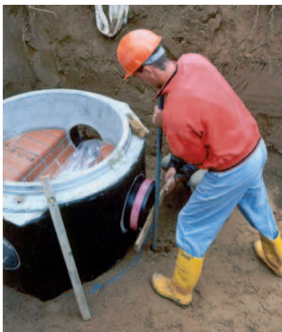
Abb. 6b ■ Montage der Abwasser-einschubmuffe
