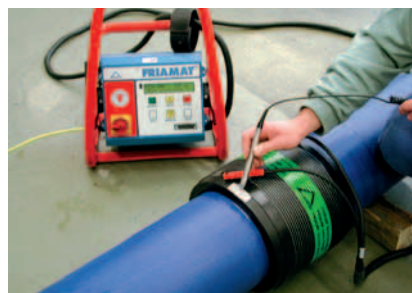
Abb. 1 ■ PE-Rohr Verbindungstechnik: Heizwendelschweißen
