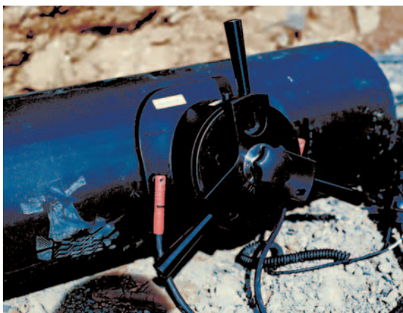
Abb. 7 ■ Abwassersattel mit Aufspann- und Anbohrwerkzeug
