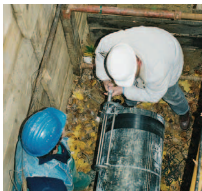
Abb. 3 ■ Die Entfernung der lagerungsbedingten Oxidhaut am Rohr zum Beispiel durch Schälgeräte ist vor jedem Schweißvorgang erforderlich.
