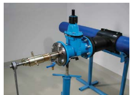
Abb. 3: Einbindung einer Abzweig-leitung über Flanschschieber. Die Befestigung des Anbohrgeräts er-folgt ebenfalls über den Flansch-abgang.
