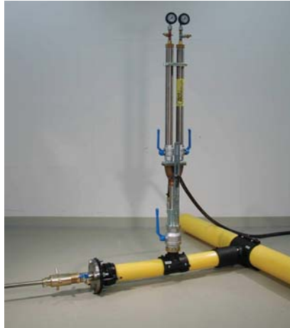
Abb. 4: Nach der Anbohrung wird der Abzweig durch Setzen einer Zweifachblase temporär abgesperrt. Die Montage des Blasen-setzgestänges erfolgt über eine Sperrblasenarmatur SPA.
