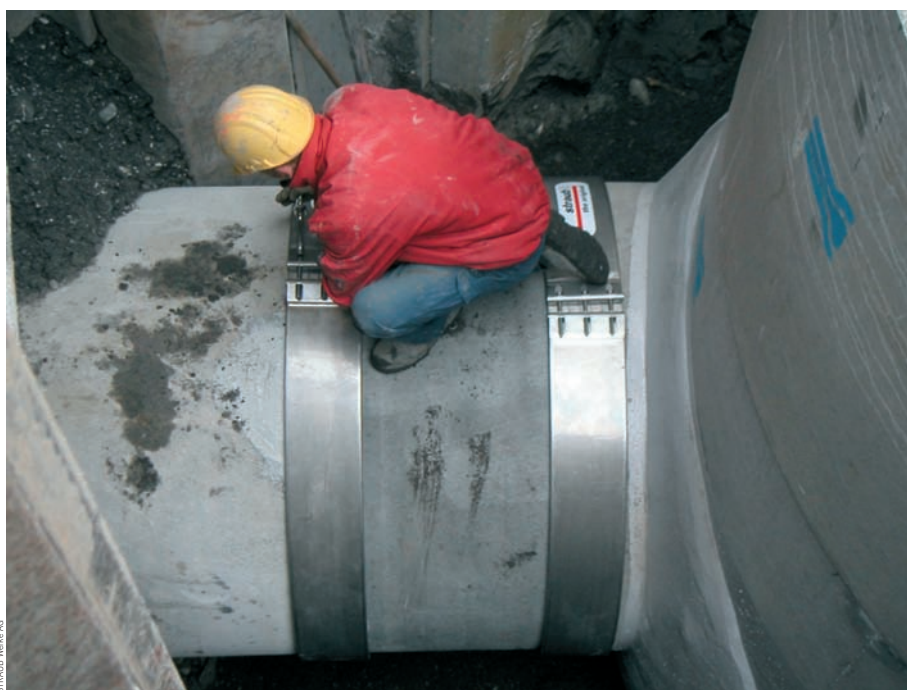
Bild 6: Gelenkige Schachteinbindung in einem Betonrohrsystem
