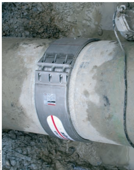
Bild 4: STRAUB-OPEN-FLEX als Ersatz für eine undichte REKA-Kupplung
