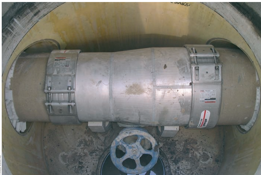
Bild 5: Einbindung eines Edelstahl-Reduzierstücks in GFK-Leitungen
