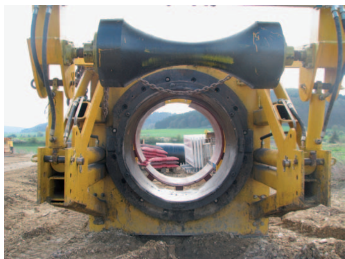
Bild 3: Swageline-Reduzierwerkzeug in der Startgrube
