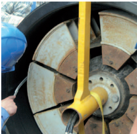
Bild 5: Einsatz des Expanders zum Aufweiten des Rohres
