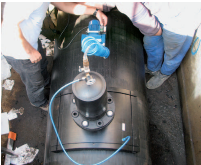
Bild 8: Schweißen des FRIALEN®-Stutzensattel SA-XL d900/DN150
