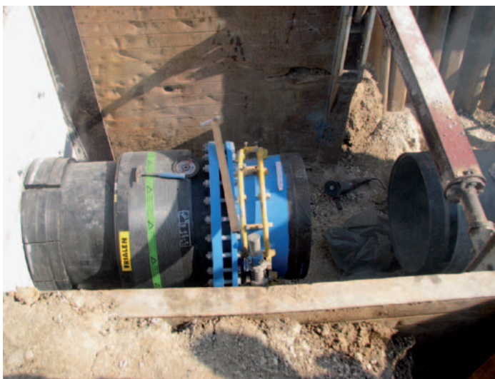
Bild 6: Fertiggestellter Werkstoffübergang PE/Stahl
