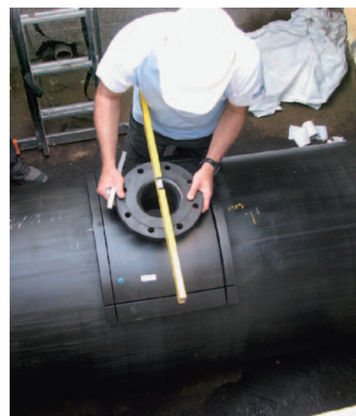
Bild 7: Ausrichten des Anschlussstücks SA-XL d900/DN150 für das Be- und Entlüftungsventil
