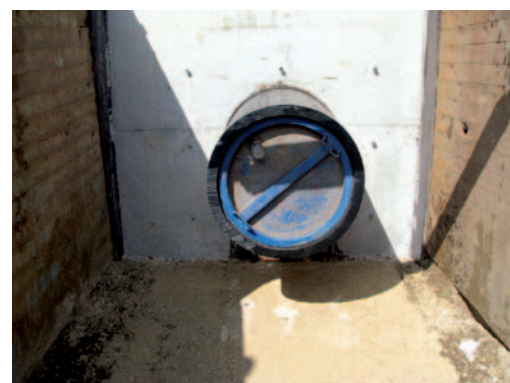
Bild 4: Inlinerstutzen ragt in der Einziehrube aus dem Altrohr
