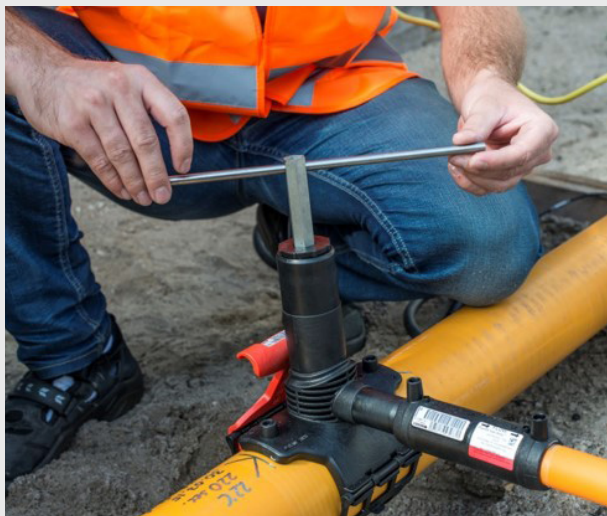
Bild 6: Anwenderfreundlich: Ein universeller Anbohrschlüssel für alle Dimensionen
