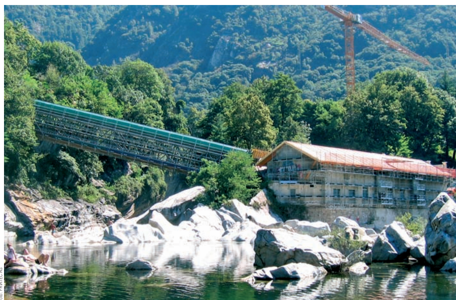
Bild 3: Turbinenhaus und Rohrbrücke des Wasserkraftwerks Ponte Brolla Fig. 3: Turbine house and pipeline bridge of Ponte Brolla hydropower station
