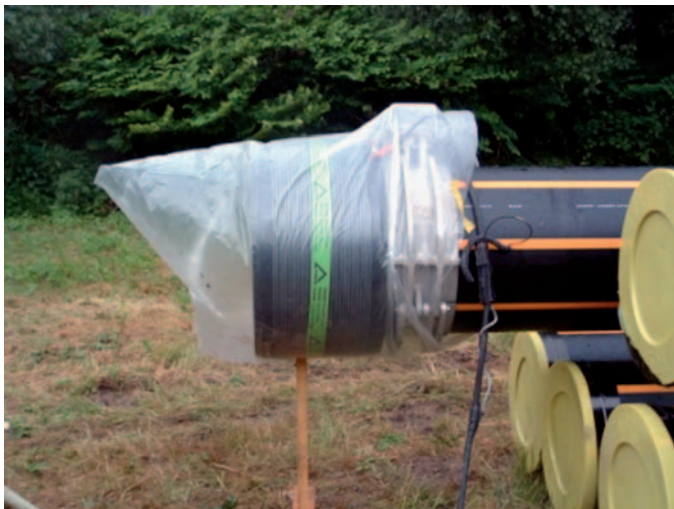
Bild 5: Schweißen der ersten Muffenseite mit leistungsstarken FRIAMAT-Schweißgeräten am Rohrlagerplatz
