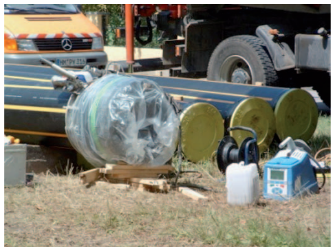
Bild 8: Abzweig und Anbindung des PE-Rohres an Altleitung/Streckenabsperriklappe mittels Flansch
