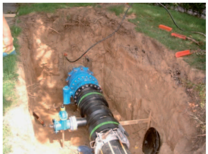
Bild 4: ...und dann im Graben in die Leitung eingebunden
