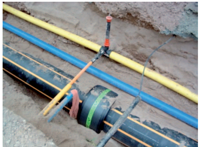
Bild 6: Schweißen der zweiten Muffenseite im Graben
