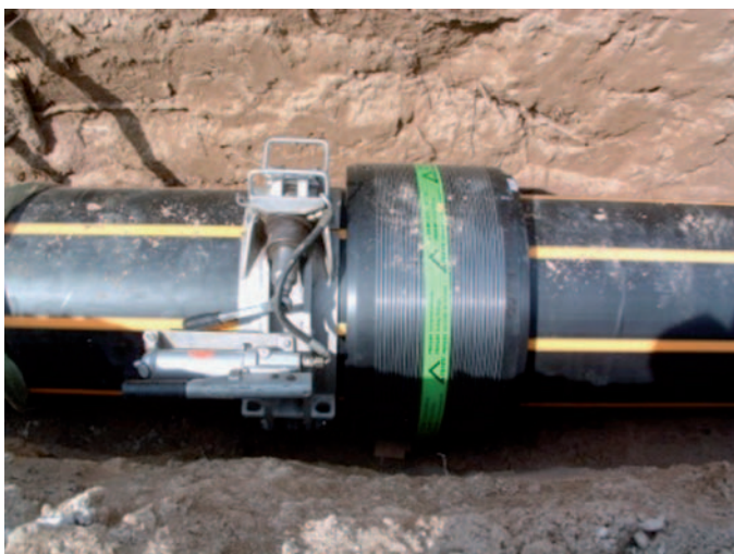
Bild 7: Vorbereitung eines Abzweigs durch ein T-Stück und Anbindung an die alte Trasse
