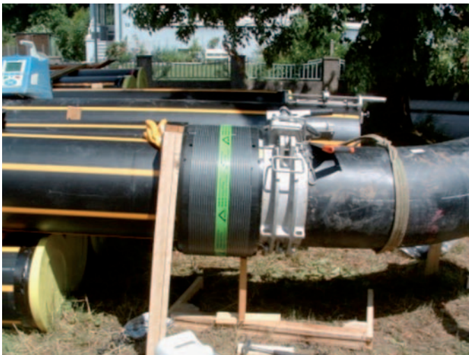
Bild 1: Vorbereitung von Hausanschlussleitungen Gas/Wasser/Strom. Der Gashaushanschluss wurde absperbar mit einem Druckanbohrventil DAV inklusive des Gasströmungswächters in der Langmuffe FRIASTOPP hergestellt
