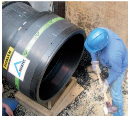
BILD 1: Gewaltfreie Montage ist für zylindrische Muffen aufgrund der Toleranzlagen nicht möglich
