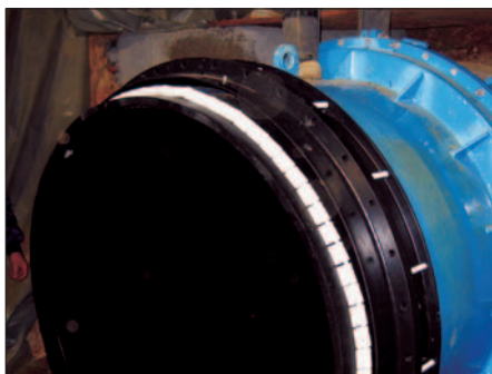
Bild 9: Montage der Greifsegmente Fig. 9: Installing of the gripper segments
