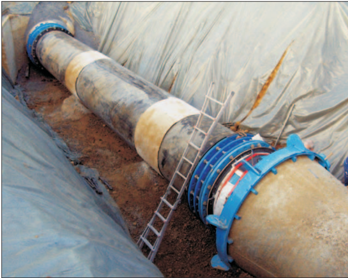
Bild 4: Vorab eingebundenes FF-Stück der Nennweite 1500
