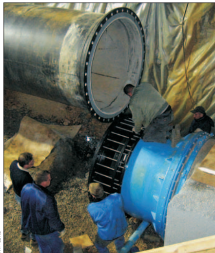
Bild 10: Einsetzen des FF-Stücks DN 1500 Fig. 10: Re-installing the flanged-ended pipe section DN 1500
