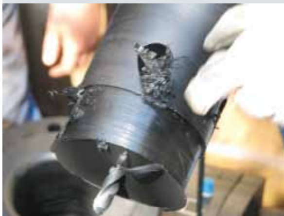
BILD 11: Anbohrung eines Rohres d 900 mm/SDR17 mit einer Wanddicke von ca. 53 mm durch das FWAB XL-Anbohrset
