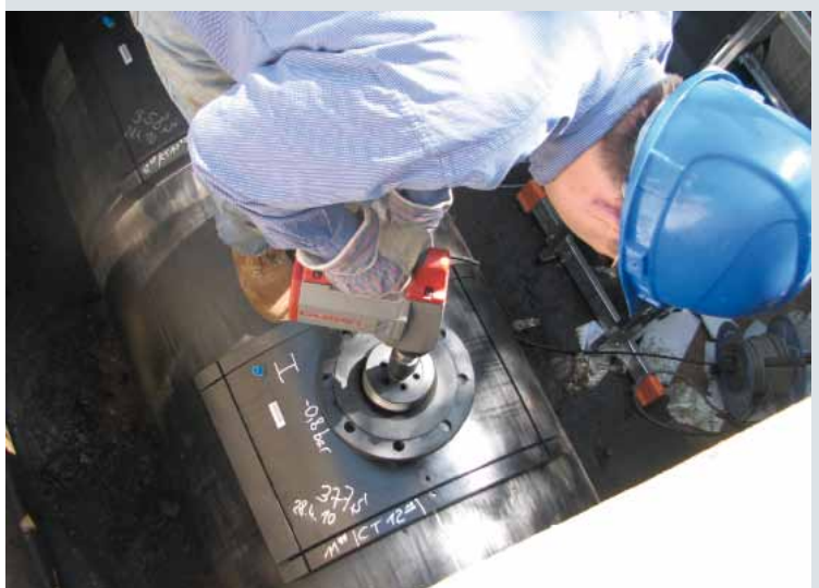
BILD 12: Rohrgleiche Anbohrung des Rohres d 900 mm mit Flanschabgang DN 150
