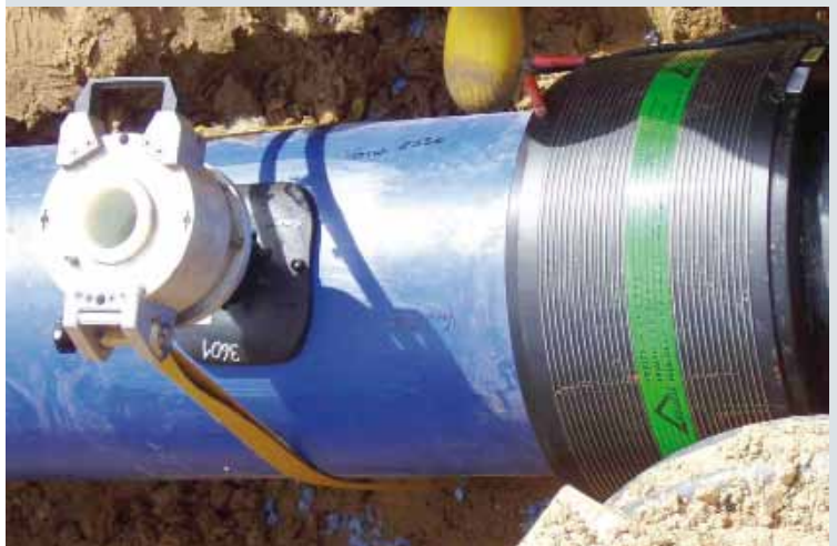
BILD 4: Entlüftungsstutzen an einer Trinkwasserleitung d 450 mm durch eine Top-Loading Stuzenschelle SA-TL
