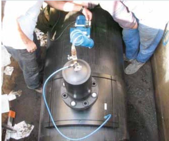
BILD 10: SA-XL d 900 mm mit Flanschabgang während der Montage mittels Vakuumspanntechnik. Der Verschluss des Abgangs erfolgt hier mit einem Blindflansch statt mit dem üblichen Presskolben
