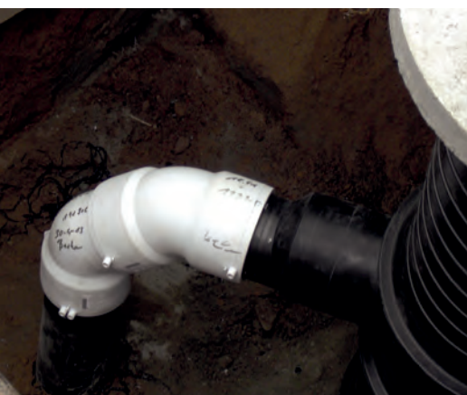
Bild 1: Materialhomogener Anschluss eines Straßeneinlaufes
