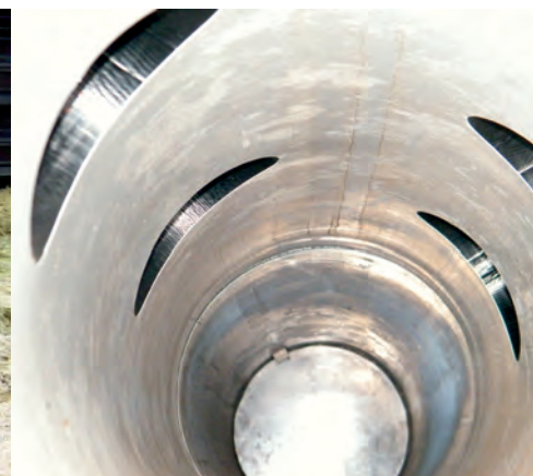
Bild 3: Blick in das Kanallinnere: Glatte, versatzfreie Einläufe; helle Innenschicht unterstützt die TV-Inspektion
