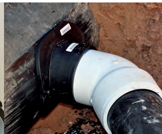
Bild 6: Anschluss mit Abwassersattel und -bogen
