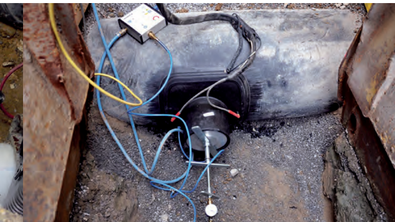
Bild 10: Mit VACUSET XL aufgespannter Abwassersattel ASA-VL
