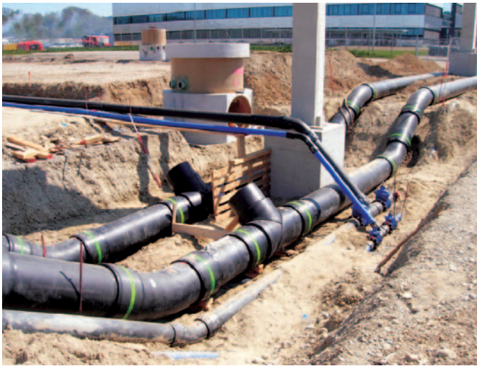
Bild 2: PE-Druckleitung d 560 mm: Einsatz der Heizwendelschweißtechnik
