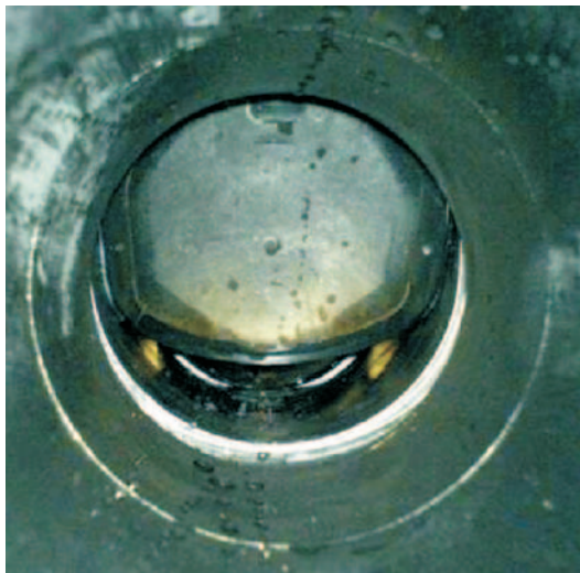
Bild 10: Nach der Prüfung: Absperrklappe, Dichtung, Gehäuse zeigen keine Verschleißspuren Fig. 10: After the test: no traces of wear on the shut-off valve, seal or housing
