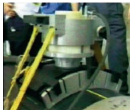
**Bild 12:** Montage des Reparaturflickens im Top-Loading-Verfahren mittels Aufspanngerät FRIATOP
