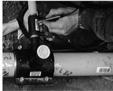
Bild 7: Einlesen von Schweißparametern und Traceability-Daten
