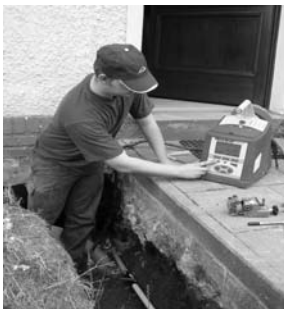
Bild 10: Dateneingabe per Funktionstasten am FRIAMAT-Schweißgerät
