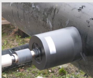
Bild 2: Anbohrung des Rohres in 9-Uhr-Position
