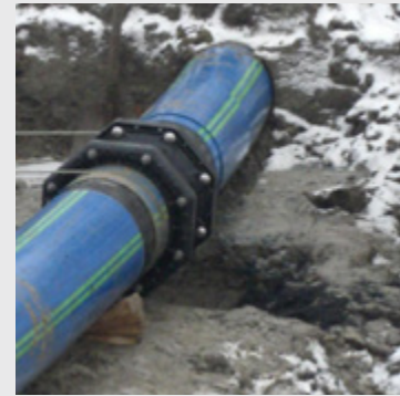
Bild 18: Verbindung Passstück und bestehende PE-Rohrwasserleitung mit FRIAGRIP-Kupplung
