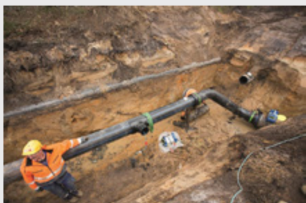
Bild 11: Einbau des Etagebogens d 355 mm/ 45°
