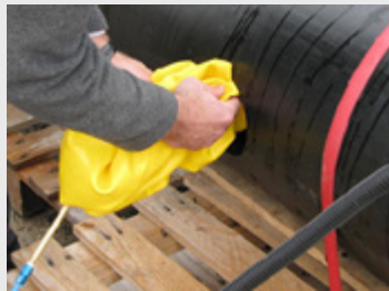
Bild 3: Einbringen des Reparaturballons
