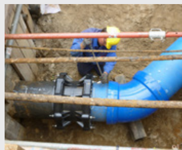
Bild 15: Einbindung der parallel zur alten Gussleitung verlaufenden neuen Leitung
