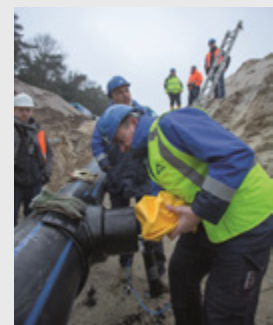
Bild 8: Einbringen des Reparaturballons
