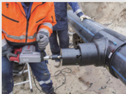
Bild 7: Anbohren der Leitung durch die Stutzenschelle SA XL d 355 / d 225mm
