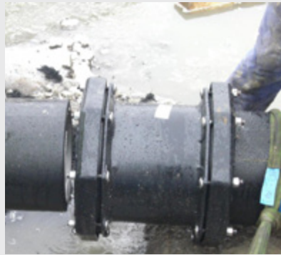
Bild 17: Innenstützhülse SHVA im linken Rohr bereits eingeschoben, FRIAGRIP-Kupplung DN 300 rechts vormontiert
