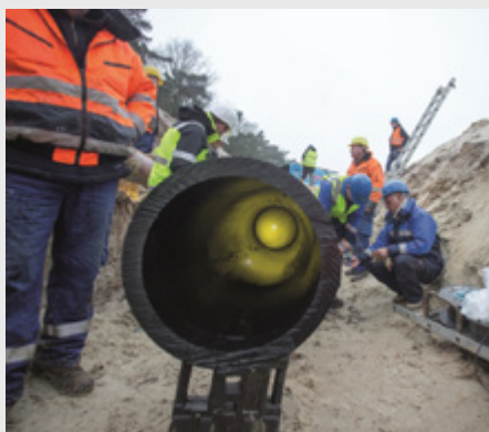
Bild 9: Der Reparaturballon dichtet im Rohr gegen nachfließendes Wasser ab
