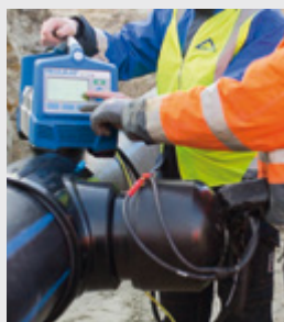
Bild 12: Schweißung einer Verschlussmuffe am Abgangsstutzen
