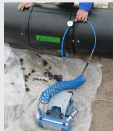
Bild 6: Ein Sattel-formstück, hier ein Reparatursattel, der mit Vakuumspanntechnik montiert wird, verschließt das Anbohrloch
