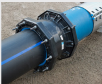
Bild 14: Einbindung PE-Rohrleitung in bestehende Guss-Leitung
