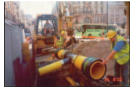
Bild 4: Einbindung eines Abzweigs in eine Gasleitung d 500 mm
