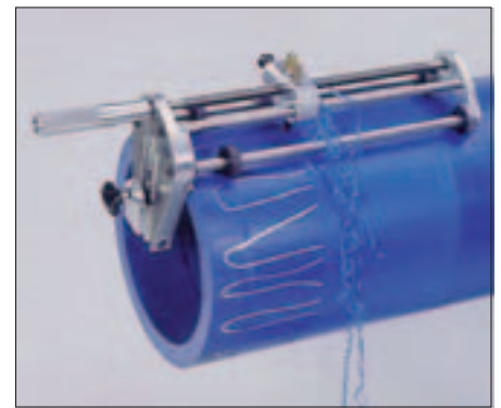
Bild 3: Professionelle Schweißflächenvorbereitung an einer Trinkwasserleitung d 355 mm mit Hilfe des Schälgeräts FWSG710L
