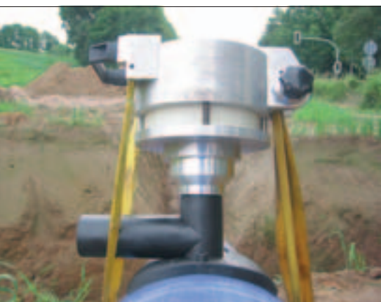
Bild 8: Anschluss an eine Trinkwasserleitung d 400 mm im Top-Loading-Verfahren
