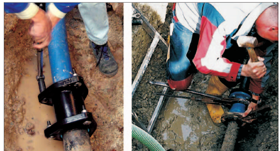
Bild 3: Gewaltfreie Montage auf empfindlichen älteren Leitungen (links) im Vergleich zu herkömmlicher Technik (rechts)
