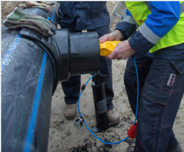
Bild 5: Einbringen des Reparaturballons
