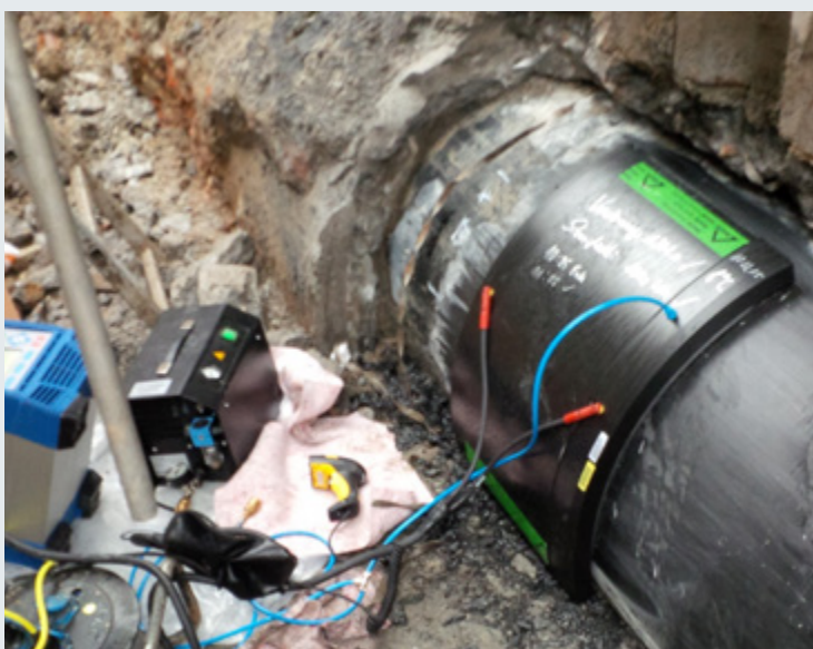
Bild 7: Ein Sattelformstück, hier ein Reparatursattel, der mit Vakuumspanntechnik montiert wird, verschließt das Anbohrloch
