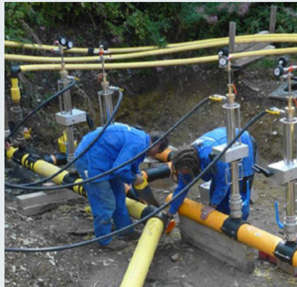
Bild 3: Einbindung einer Gasleitung unter 3,1 bar Betriebsdruck unter Einsatz der Sperrblasentechnik
