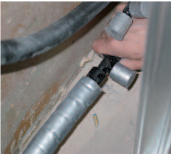
Bild 8 • Die Zuordnung von Anfasern und Formteilen ist bei FRIATHERM multi durch die Farbgebung der Schutzkappen unkompliziert.
