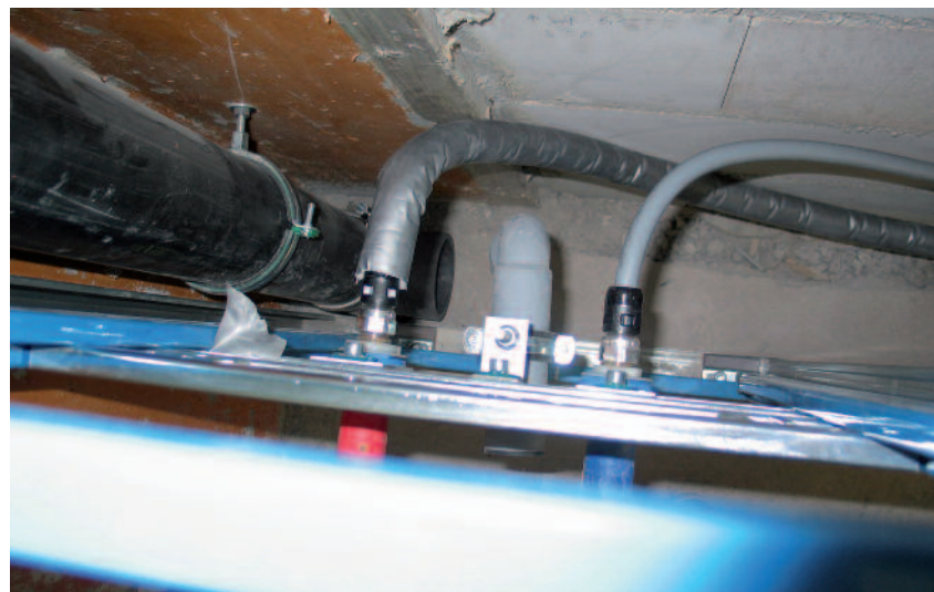
Bild 6 (oben) • Gerade in beengten, schwer zugänglichen Montagesituationen ist immer Platz für den werkzeugfreien, nur mit den Händen ausgeführten Steckvorgang.
