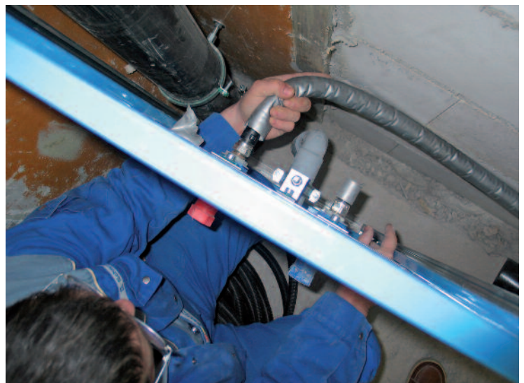
Bild 6 (oben) • Gerade in beengten, schwer zugänglichen Montagesituationen ist immer Platz für den werkzeugfreien, nur mit den Händen ausgeführten Steckvorgang.
