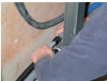
Bild 4 • Ein gutes „Handwerk“: Ab-längen. Anfasen. Stecken. Nur drei schnelle und unkomplizierte Arbeitsschritte und schon ist der Verbindungsvorgang abgeschlossen
