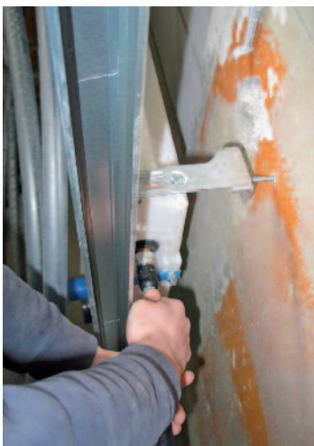
Bild 5 • Zusammen mit vorgefertigten Bauteilen lassen sich mit Steckverbindungstechnik Bauabläufe vereinfachen und optimieren.
