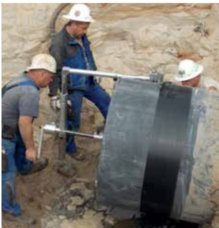
Schälgerät FW5G XL im Einsatz
