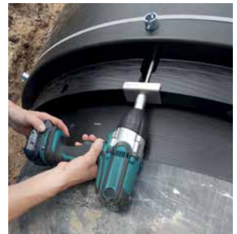
Keilaktivierung mittels Akku-Schrauber
