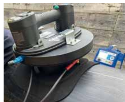
Während des Schweißvorgangs wird das Vakuum gehalten.
